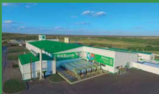
ООО «КСМК-Север» пос. Кадамовский, Ростовская область
